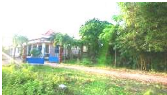
Ảnh 16: Nhà máy cấp nước Võ Xu
