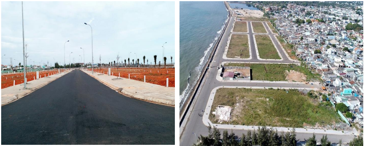
Hình 2. Hiện trạng hạ tầng khu vực dự án
