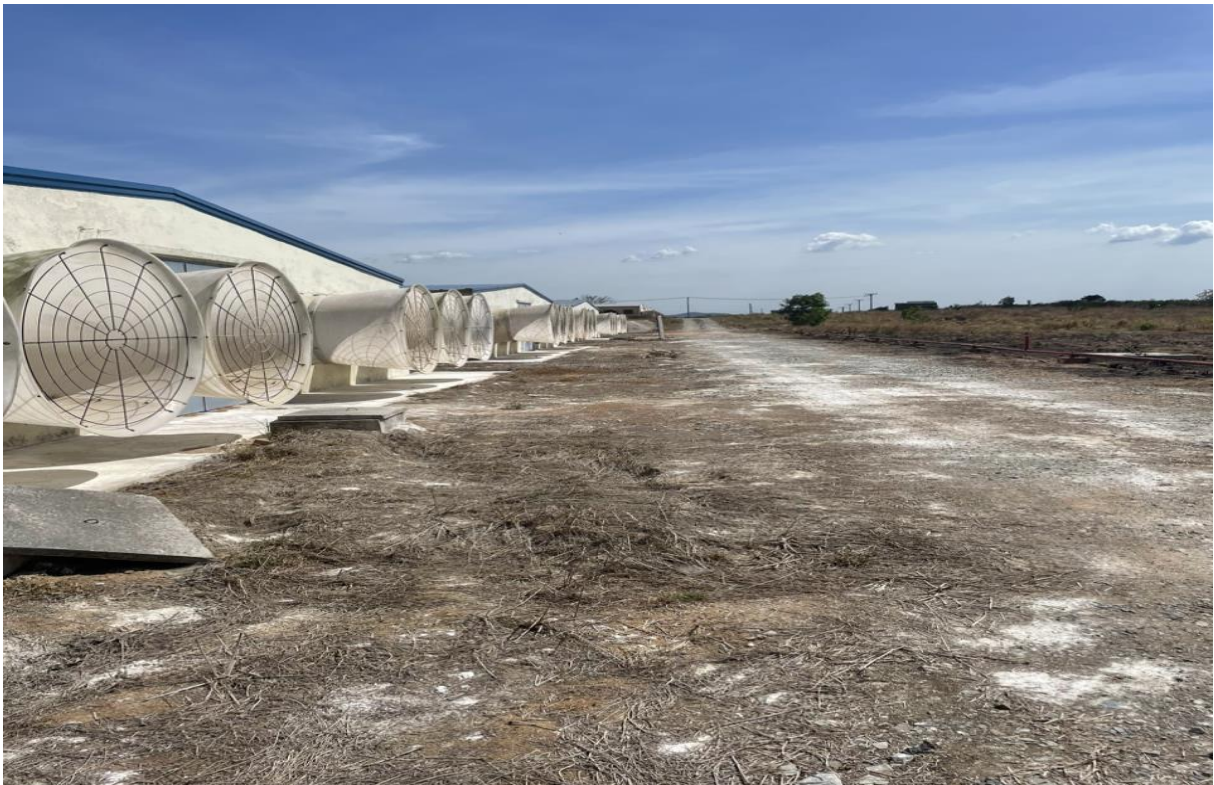
Hình ảnh Hệ thống quạt hút phía sau các dãy chuồng nuôi của Trang trại
