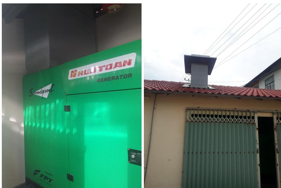
Hình 16. Khu vực máy phát điện và ống khói tại khu khách sạn
