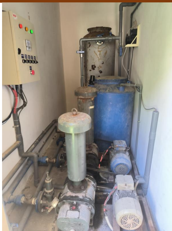
Hình 9. Hệ thống xử lý nước thải tại khu A
