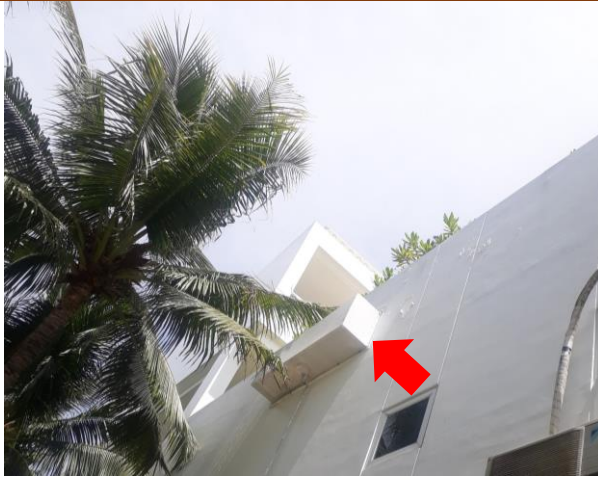
Hình 8. Hệ thống hút mùi và ống khói tại nhà bếp
