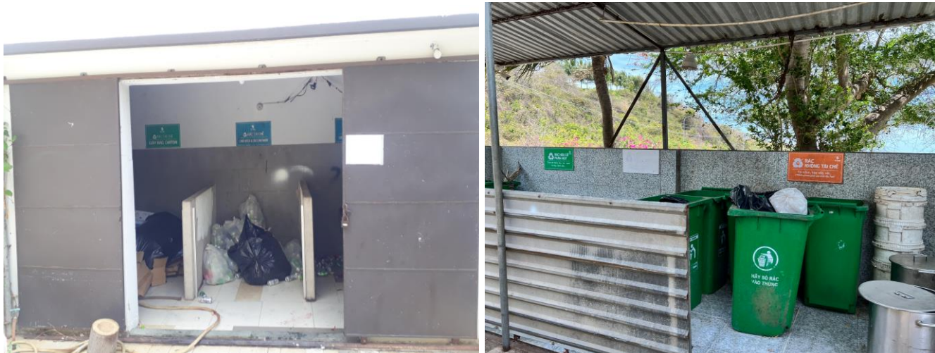
Hình 10. Kho chứa rác thải sinh hoạt và khu vực tập kết rác
