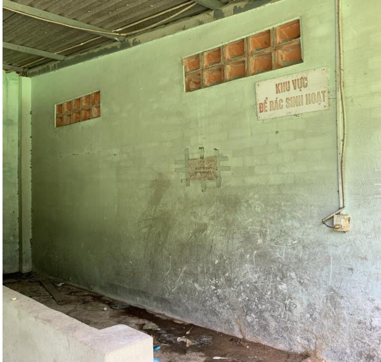
Khu vực chứa rác sinh hoạt
