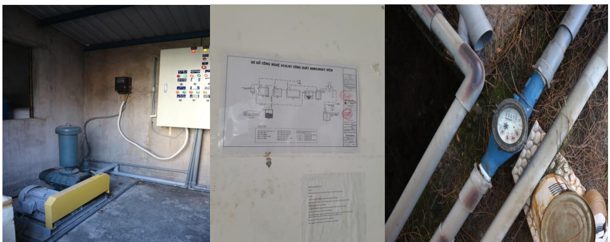
Hình 10. Đồng hồ điện, đồng hồ nước, sơ đồ công nghệ của HTXLNT
