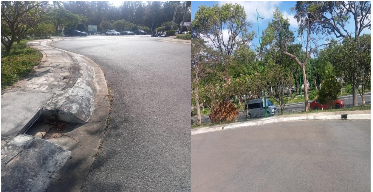
Hình 2. Mương thu nước mưa xung quanh khách sạn.
