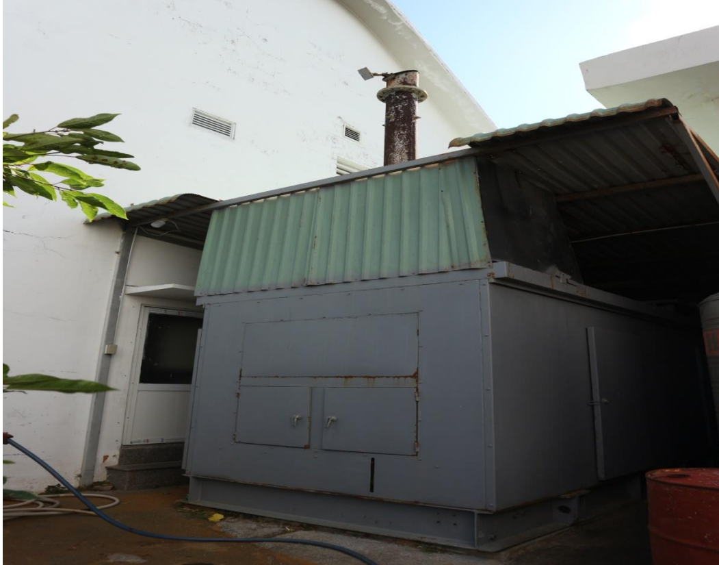
Hình 18. Nhà đặt máy phát điện dự phòng có khung, bệ, vỏ máy được thiết kế đảm bảo giảm ồn, rung
