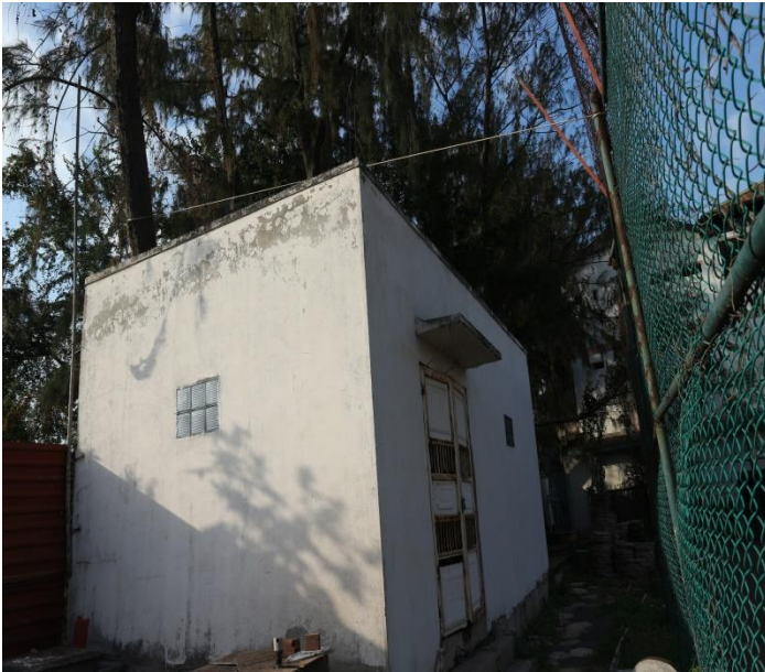
Hình 19. Nhà vận hành HTXLNT
