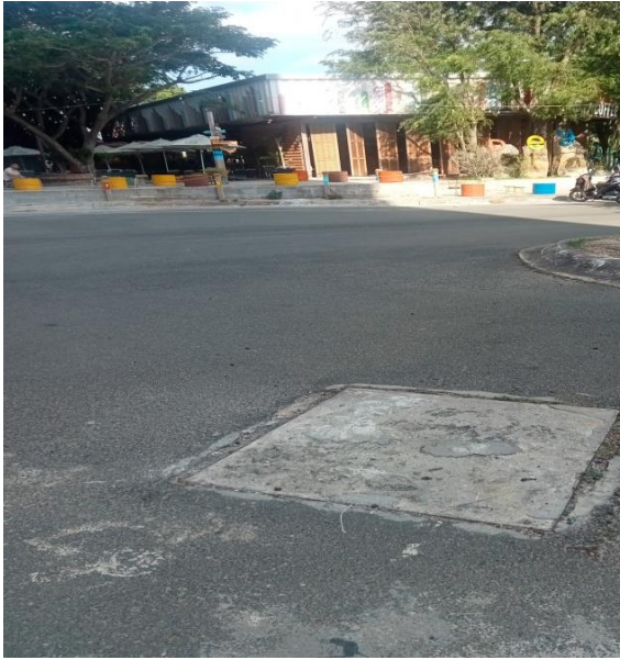
Hình 3. Hồ ga thu nước mưa từ hộp gen xuống
