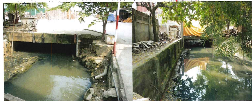
Ảnh hiện trạng mương thoát nước
