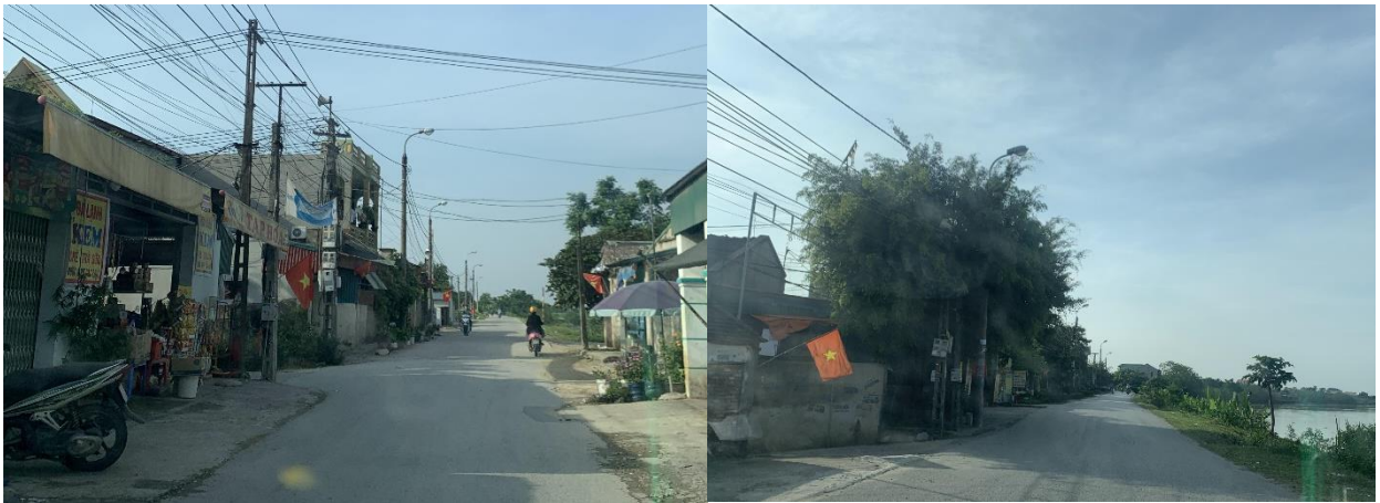
Hình ảnh: Hệ thống chiếu sáng trên địa bàn xã Hoàng Quang
