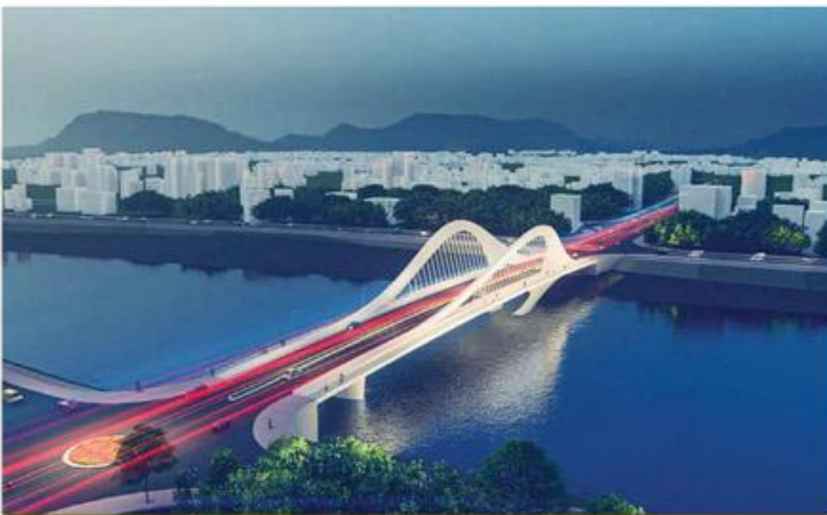
Cầu Quang Vinh 1 là cầu dầm hộp và dầm bản kết hợp vòm thép, có tổng chiều dài gần 312 m, chiều rộng mặt cầu tại nhịp chính là 29 m
