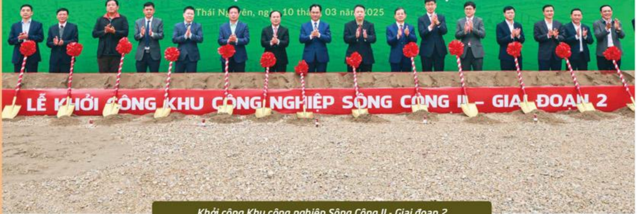
Khởi công Khu công nghiệp Sông Công II - Giai đoạn 2
