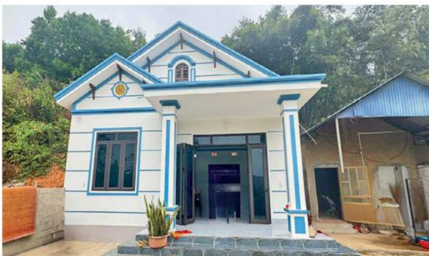
Ngôi nhà mới được xây dựng từ Chương trình xóa nhà tạm của gia đình bà Văn Thị Dung, xóm Chiềng, xã Phú Cường (Đại Từ)
