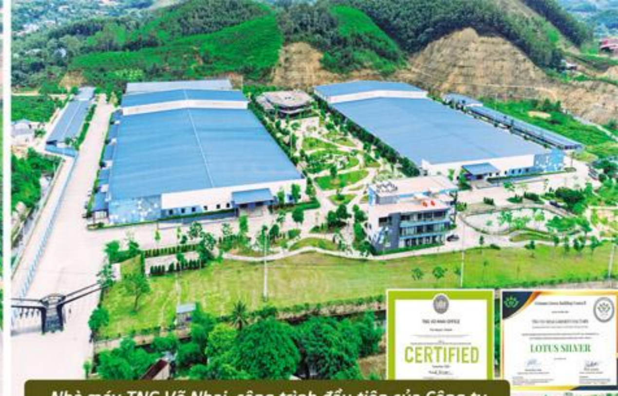
Nhà máy TNG Võ Nhai, công trình đầu tiên của Công ty được xây dựng theo hướng thân thiện với môi trường
