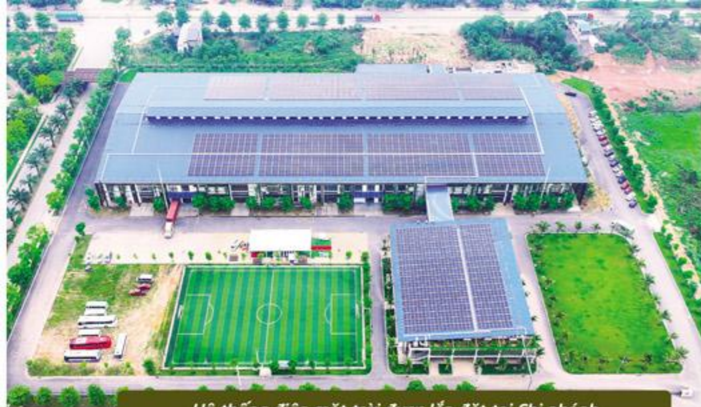
Hệ thống điện mặt trời được lắp đặt tại Chi nhánh May Việt Thái. (Ảnh: Mạnh Thắng)
