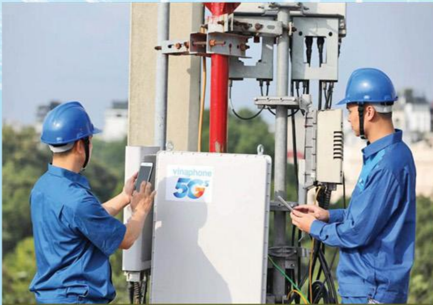
VNPT Thái Nguyên lắp đặt trạm phát sóng 5G.
