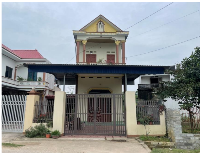
Hình 7a: Hiện trạng nhà dân dọc tỉnh lộ 262
