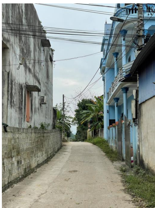
Hình 9m: Hiện trạng cột điện hạ thế trong các khu làng xóm.
