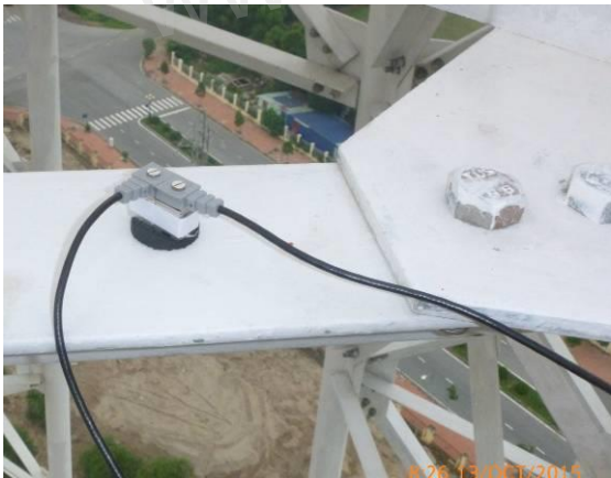
Hình 9.1 - Bố trí đầu đo dao động trên thanh giằng ngang
