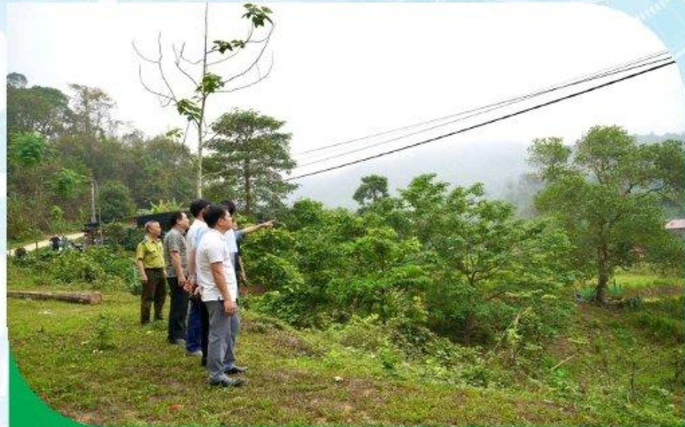
Đại diện Sở Khoa học và Công nghệ, doanh nghiệp viễn thông, chính quyền cơ sở khảo sát vị trí lắp đặt trạm BTS tại xóm Tân Lập, xã Sáng Mộc
