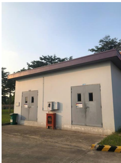
Hình 24. Kho chứa chất thải nguy hại và nhà chứa hóa chất hiện tại của Nhà máy
