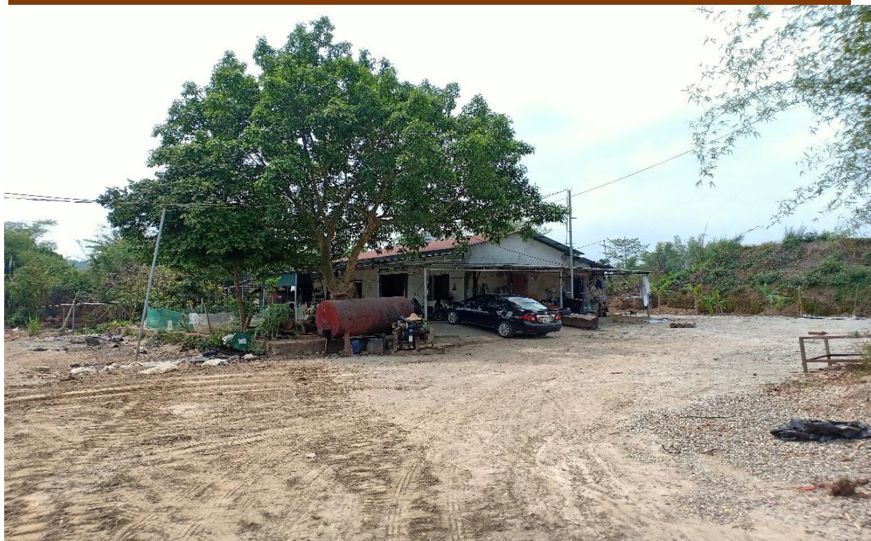
Hình 1.5. Khu vực nhà điều hành
