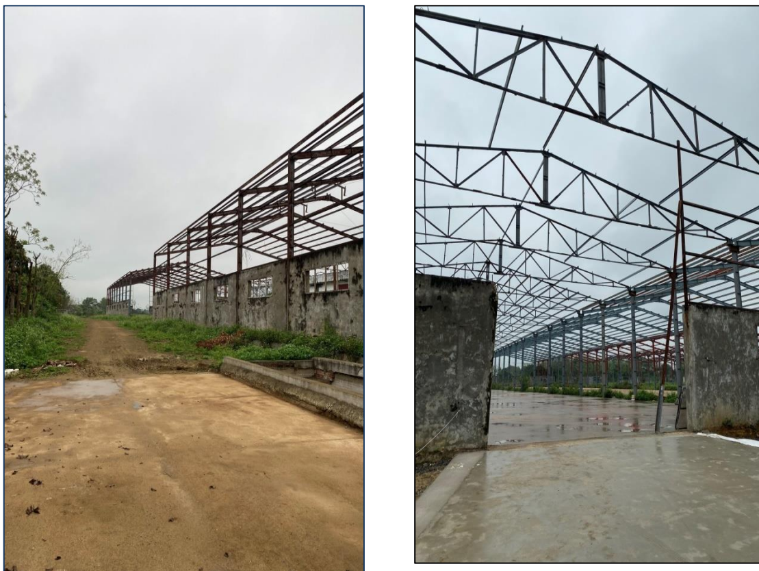
Hình 1.1. Hiện trạng nhà kho cũ tại khu vực dự án
