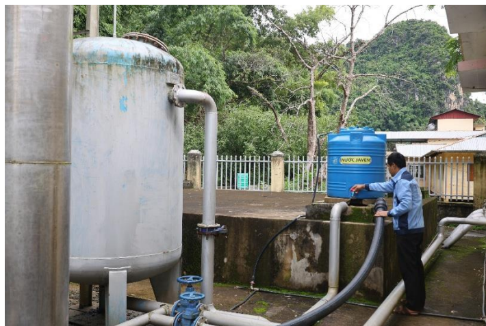
Trộn clo bể chứa bằng thủ công. Ảnh: Nguyễn Sơn.
